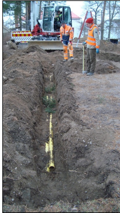
Kuva 20. Koeojaa 1, kuva luoteeseen.
