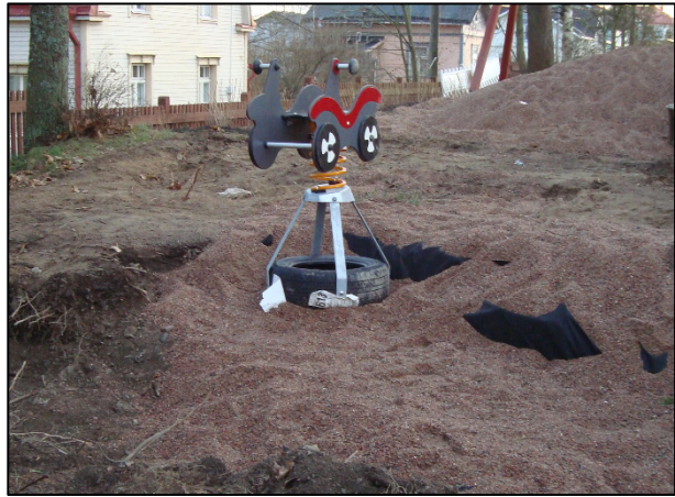
Kuva 15. Koekuppaan 11 asennetaan leikkivälinettä, kuva itään.
